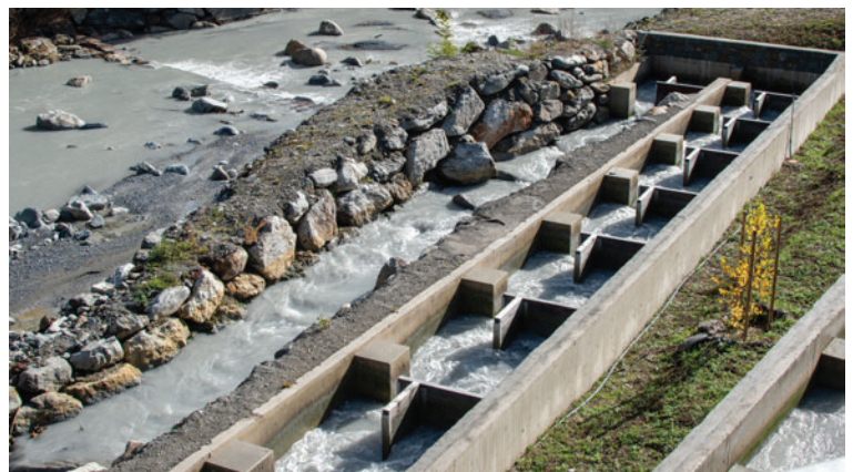
Fischtreppe – Wasserkraftwerk Laas
